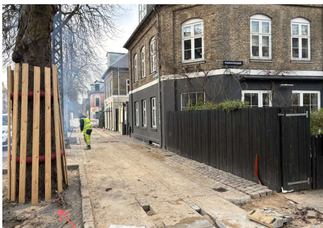
Figur 5.4 Etableret vandrende på strækningen J. A. Schwartz Gade til Voldmestergade (strækning H) til venstre og strækningen Hallingsgade – J.A. Schwartz Gade (strækning G) til venstre. Foto fra besigtigelse 9. marts 2026.
