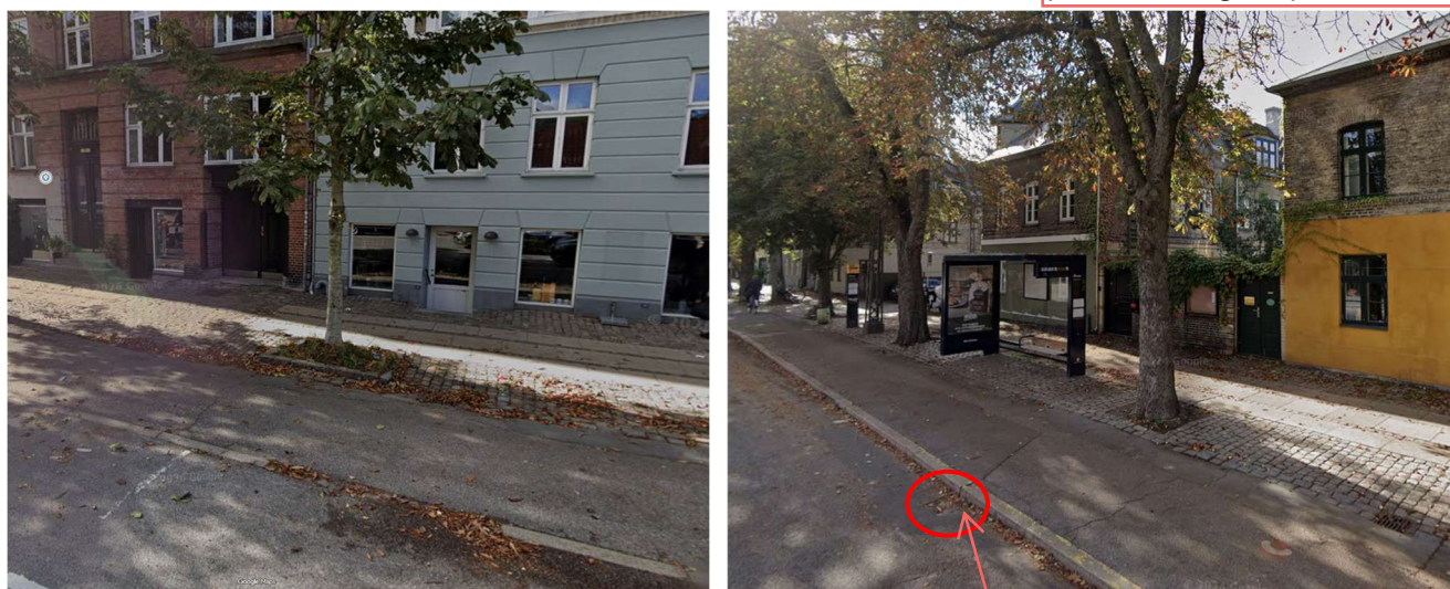
Figur 3.2 Billeder af de eksisterende (tidligere) forhold på strækningen I (Voldmestergade – Zinnsgade) til venstre, og strækning F (Høyensgade – Hallindsgade) til højre. Der ses ansamling af blade og kastanjer i efterårsperioden. Kilde: Google Streetview. Billederne er taget i september 2024.
