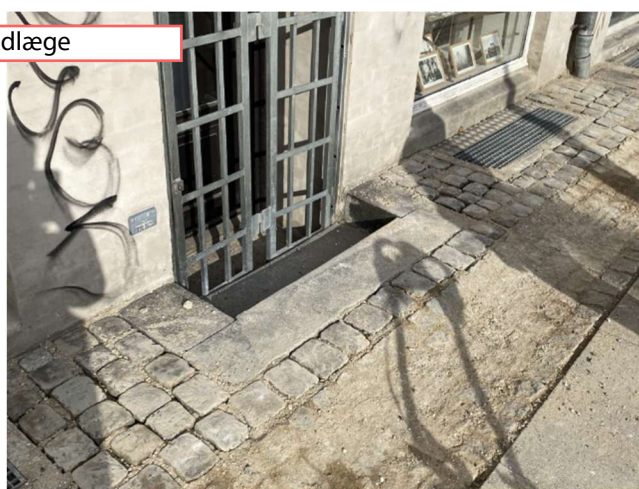
Figur 5.3 Fotos af de nyanlagte forhold på strækningen Voldmestergade – Zinnsgade (strækning I). Der er seks trappenedgange. Billedet nederst til venstre viser, at kanten af vandrenden er højere end koten for trappetrinet til kælderens. Vandet kan passere mellem rillerne i chausséstenene. Den reelle dybde af vandrenden er på dette sted lavere end 3 cm. Foto fra besigtigelse 9. marts 2026
