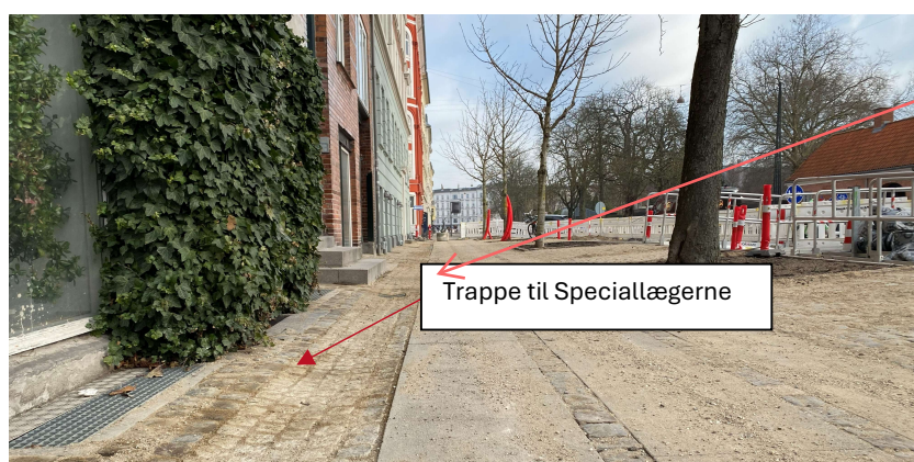
Figur 5.1 Vandrenden på en af de to kritiske delstrækninger af strækning I Voldmestergade – Zinnsgade. Der ses både en trappenedgang og en lyskasse i niveau med vandrendens kant. Trappenedgangen er inde i efeuen.
